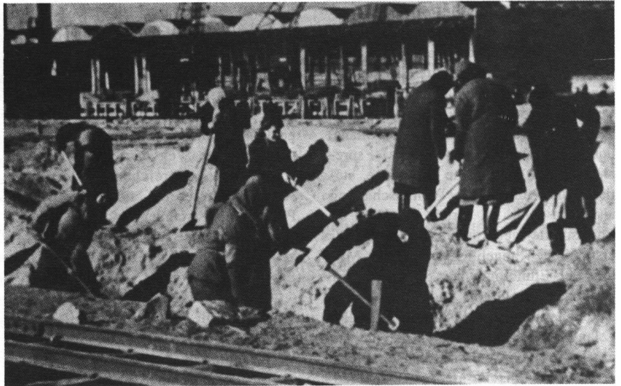
Zwangsarbeiterinnen beim Bau des Diestel-Kais
